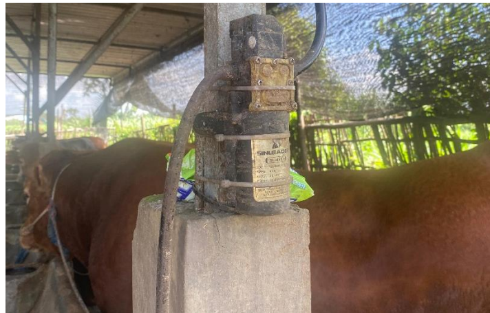
Gambar 4. Akutuator untuk kontrol pendinginan
