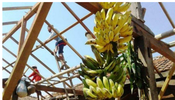
Gambar 2. Uborampen yang telah terpasang
