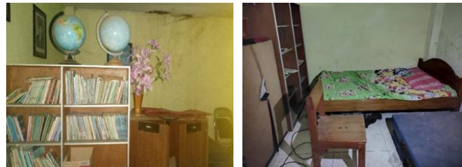
Gambar 7. Kondisi Fisik Perpustakaan dan UKS
