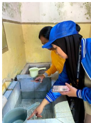
Gambar III. 4 Pengecekan Kamar mandi di rumah warga RW 1 RT 1
