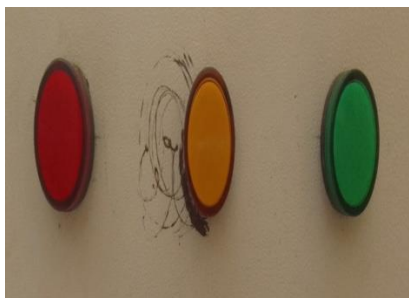
Gambar 12. Lampu Indikator 3 Fasa
