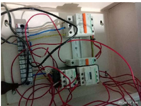
Gambar 4. Bagian Dalam Panel
