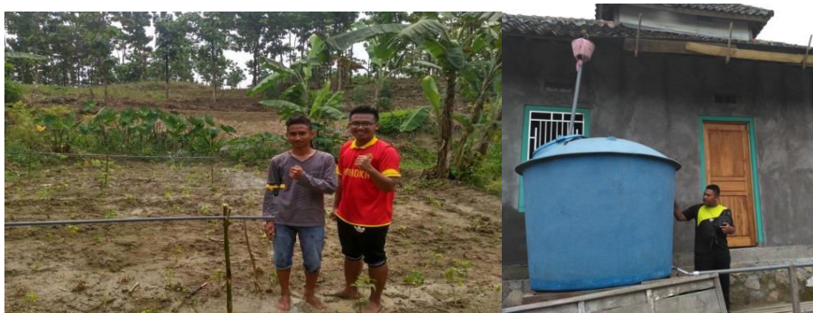
Gambar 2. Lahan kering dengan pemasangan sprinkler yang terhubung dengan pipa pada bak penampungan air hujan memanjang di desa Ngepung Kabupaten Nganjuk
