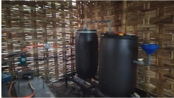
Gambar 4. Biodigester
